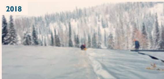
Geomembrane installation
